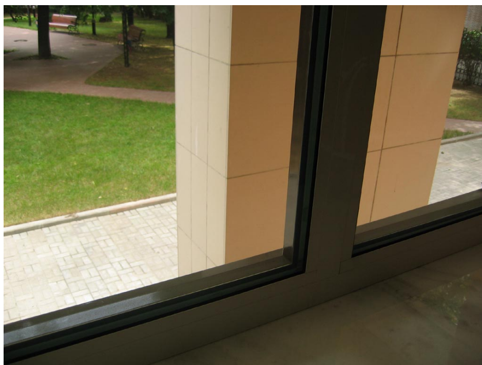
Бронированная рама из алюминиевого профиля
